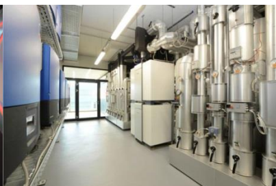
機械室 ヒートポンプ
