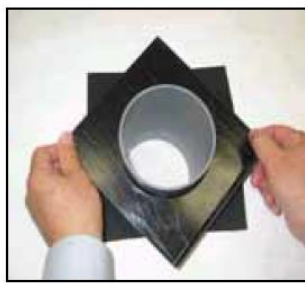
パイプ受けを治具として押し込む
