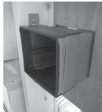
③ 防火パイプ／金属パイプ上下に面からペフを貼り付けます。
