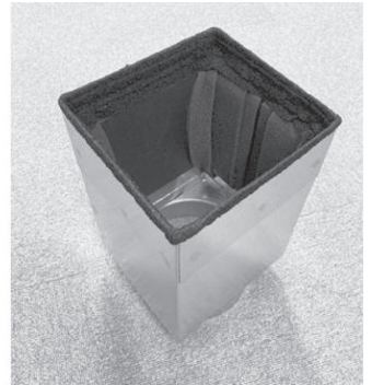
④ 端部のはみ出した部分を外側に折り返し、貼り付けます。
