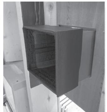
④ 側面に貼り付けると共に1枚を半分に切断し、固定金具部に貼り付けます。
