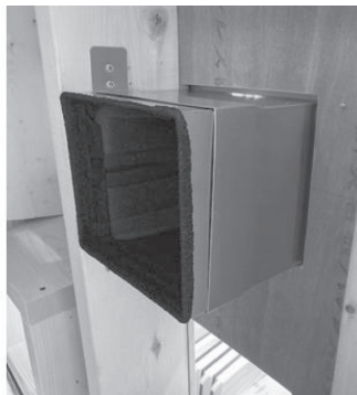
② 固定金具をネジ4本で固定します。
